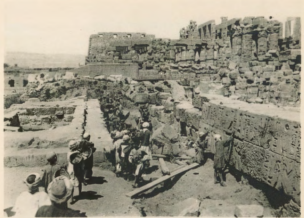
1. — Déblaiement de l'enceinte de Ramsès II, 24 mars 1923.
